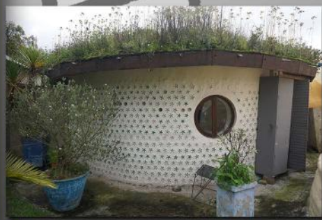
Toit végétal et mur en bouteilles
